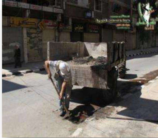
حملة تنظيف مطريات الصرف الصحي في مخيم اليرموك
